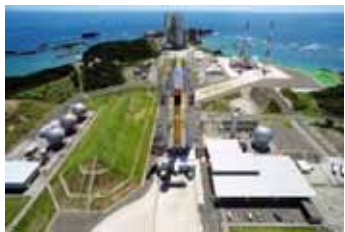
打上施設設備
