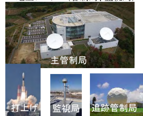
地上システム(管制局、監視局)
