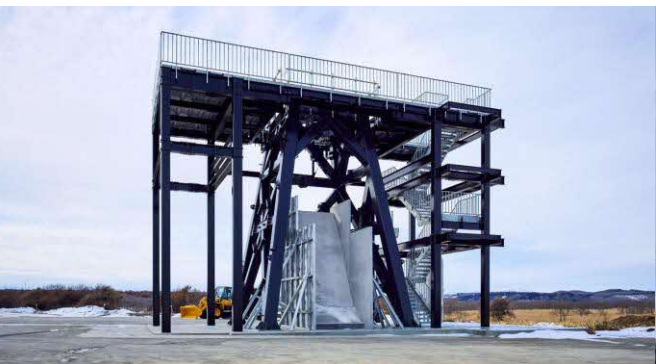
2段ステージ試験設備 (LC0)
