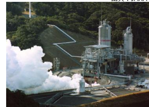
液体ロケットエンジン燃焼試験設備
