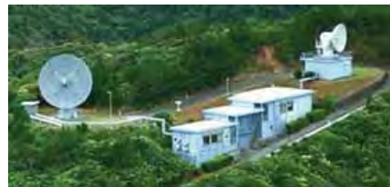
ロケット追尾局空中線設備
