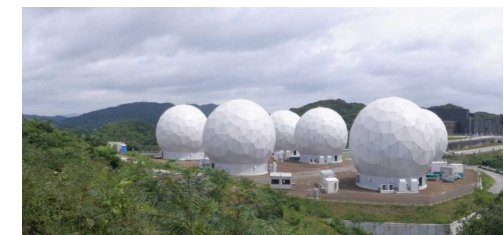
S S Aレーダー
