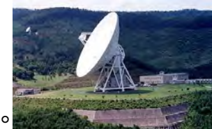
現行64mアンテナ局（整備後30年）
