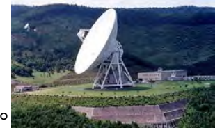
現行64mアンテナ局（整備後30年）
