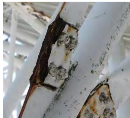
内之浦34m局（右図は老朽化状況：錆が生じている）
