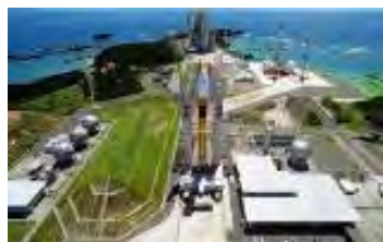
打上施設設備
