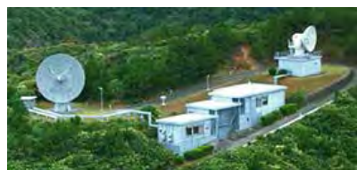
ロケット追尾局空中線設備
