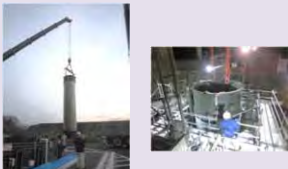
モータケース実機大強度試験 (IA富岡工場)
