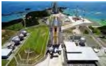
打上施設設備
