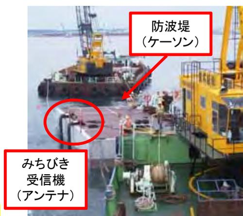
防波堤(ケーソン)の据付にあたり、みちびきの高精度測位により正確な位置を確認し、据付を行う。
