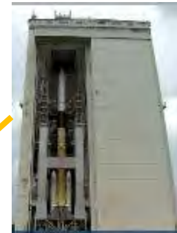
大型ロケット 組立棟
