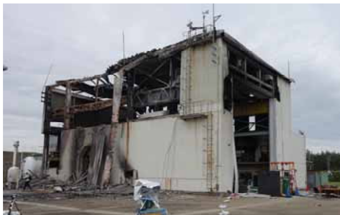
真空燃焼試験棟(爆発後)
