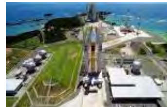
打上施設設備
