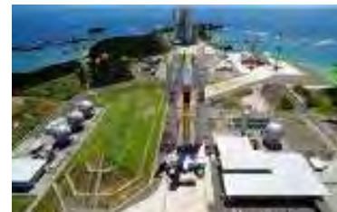
打ち上げ施設設備
