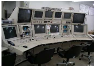
レーダ管制・処理装置(保守停止)
