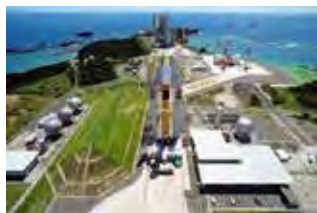
打上施設設備
