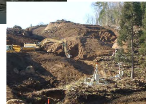
火山監視・地すべり災害復旧現場
