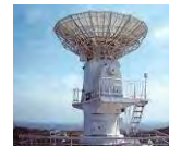
新精測レーダ設備 @内之浦
