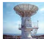
新精測レーダ設備 @内之浦
