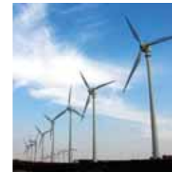
風力発電プラント
