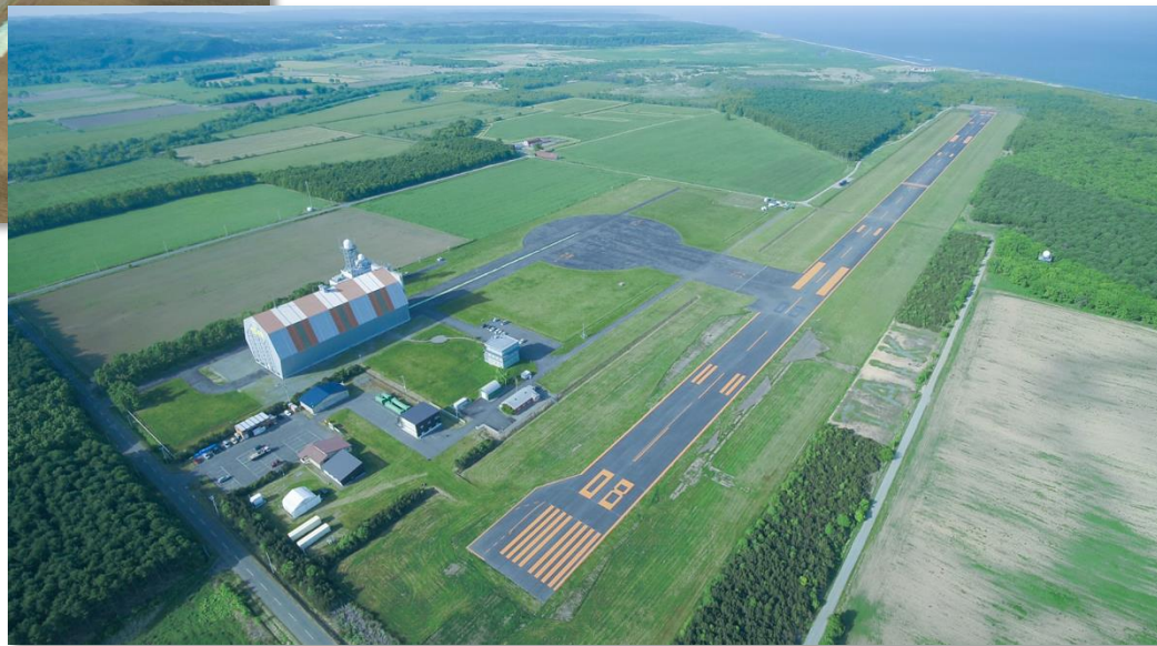
2024年6月延伸工事完成
