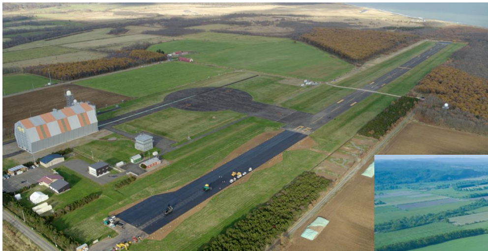
2023年 延伸工事中
