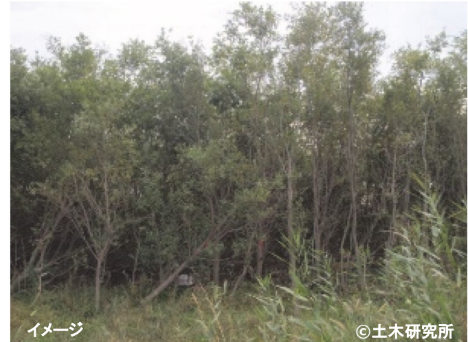
河川における樹木の繁茂状況
