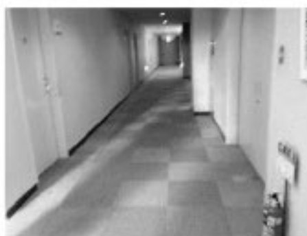
廊下カーペットの張り替え （共同作業）
